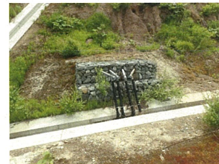
地下水排除工
