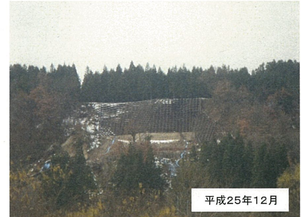
地すべり対策工
