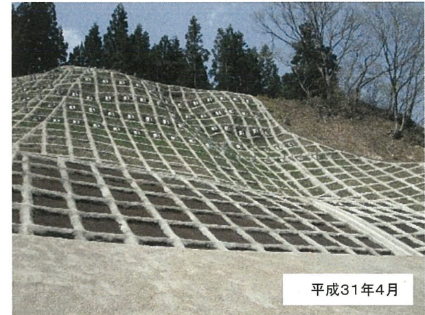
地すべり対策工
