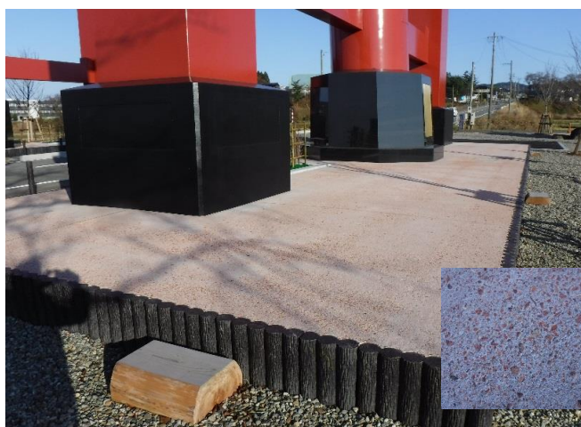
柱の土台と舗装表面
