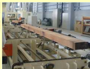
大径材製材施設
