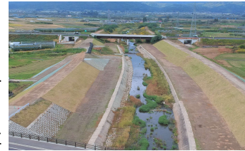
令和2年7月豪雨被災箇所での堤防復旧・高上げ工事
