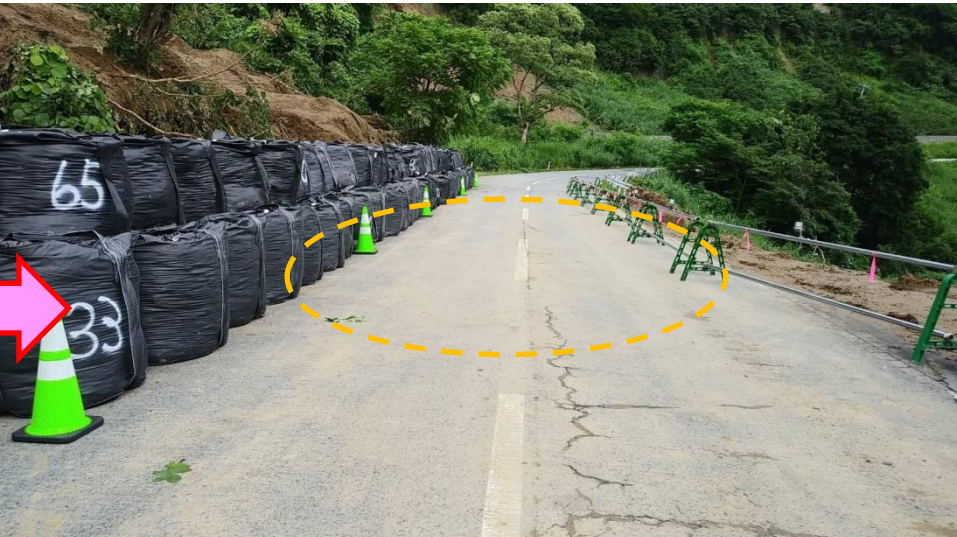
応急復旧状況
