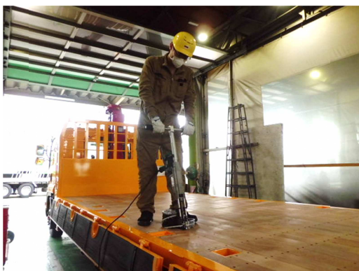
▲ ビス打ち作業の様子
