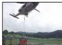
消火パケット取付作業
